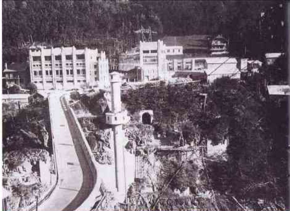
La construction de la centrale
