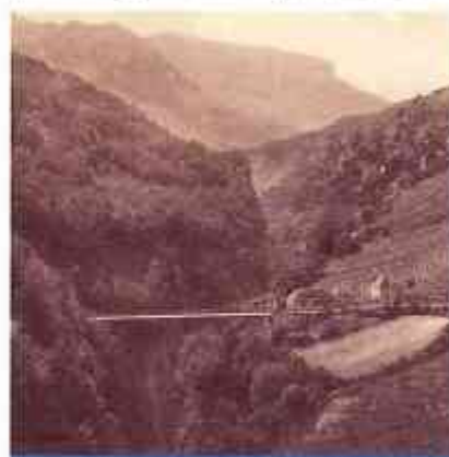
L'ancien pont du Sautet
